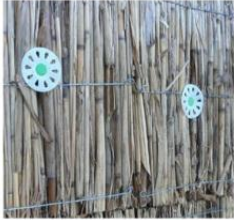
1. Tassello di fissaggio per cannucciato con piastra di metallo per l'ancoraggio.
