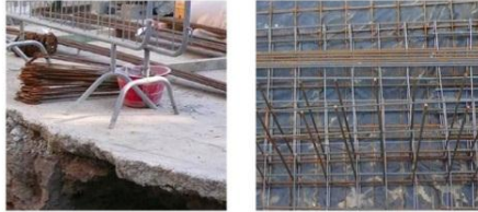
1.Particolare demolizione 2.Particolare armatura platea
