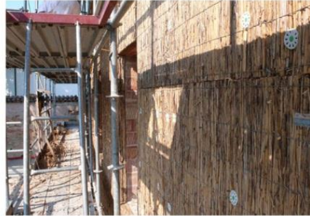
1. Tassello di fissaggio per cannucciato con piastra di metallo per l'ancoraggio.
