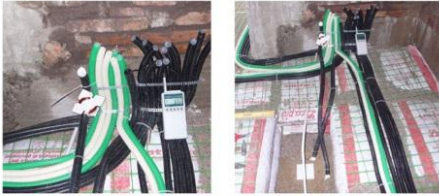
1. Tubazione per impianti 2. Piastre misurazione umidità
