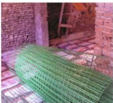
1. Rete in fibre di vetro Fibre-net
