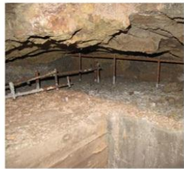
1.Dettaglio raccordo C.A. con la muratura.
