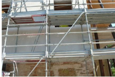
1. Intonaco a base di calce idraulica naturale
