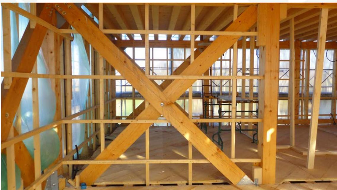
In questo cantiere lo stato dei lavori è più avanzato rispetto al fabbricato di Vigarano Mainarda ed è stato possibile vedere i tamponamenti in canapa e calce, le pareti divisorie in lastre di gessofibra con telai in legno ed isolante in pannelli di fibra di canapa, i massetti isolanti in canapa e calce, un impiantistica più definita, alcune prove di intonaco a base di calce e cocchiopesto colorato.
