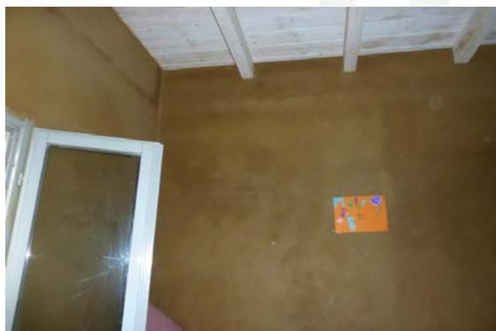
L'ultima tappa del "Tour della Canapa" è stata la visita al cantiere ove è in corso la ricostruzione post sisma di un edificio residenziale: "casa Zucchi", a Motta di Cavezzo (MO). Si tratta di un fabbricato con struttura intelaiata in legno massiccio, con tamponamenti eseguiti in opera in canapa e calce.
