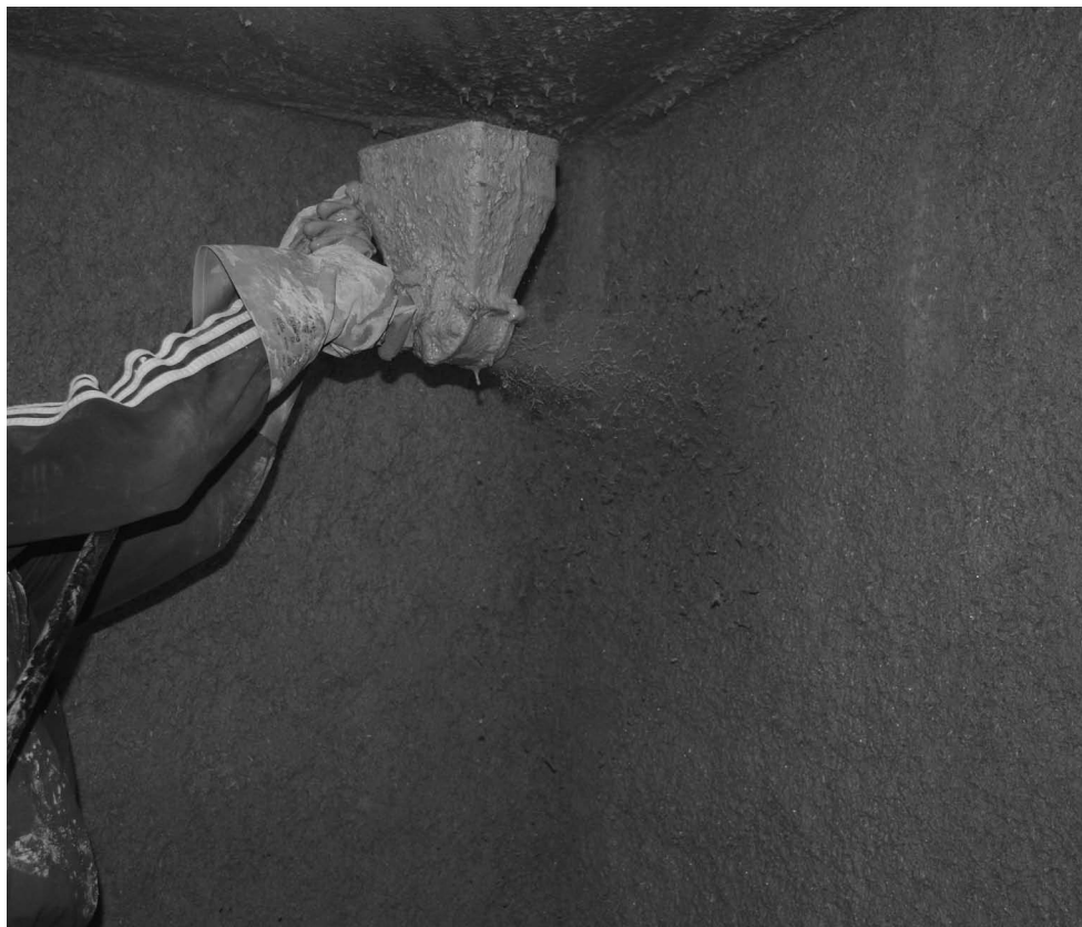
Proiezione con intonacatrice
