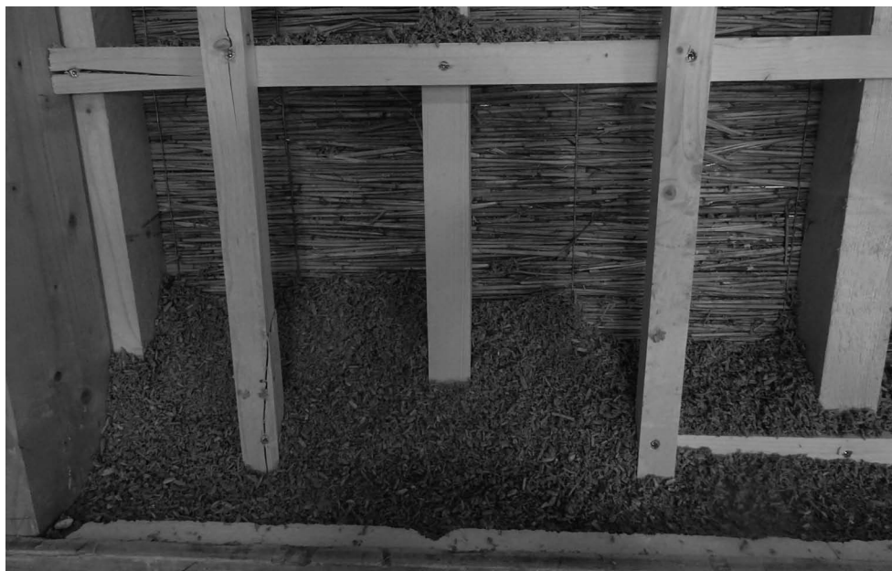
Sezione del muro in Canapa e calce gettato in opera
