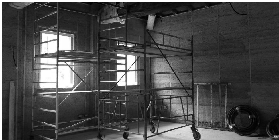
Isolamento interno in Canapa e calce «in casseri» nella sala polifunzionale
