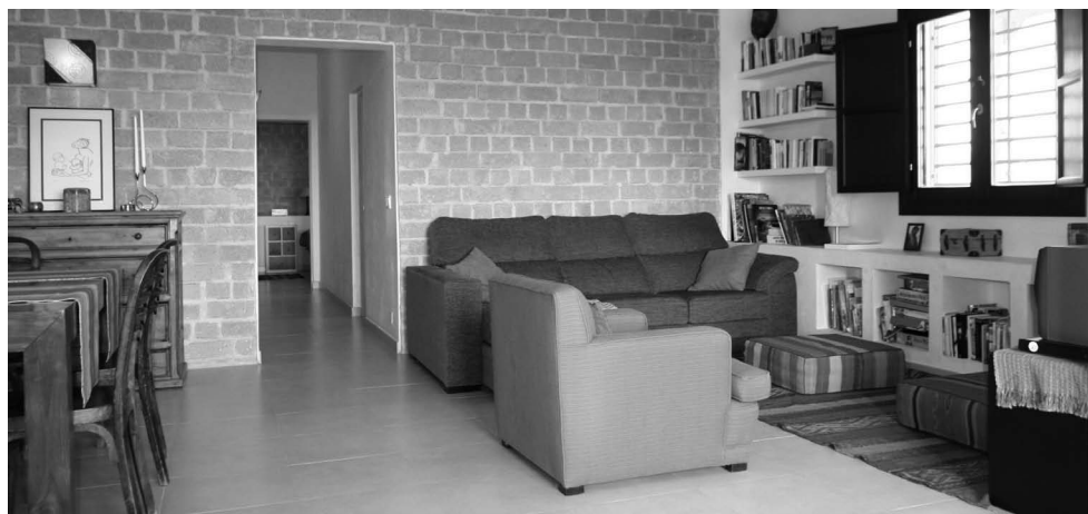
Parete del soggiorno in blocchi di Canapa a vista
