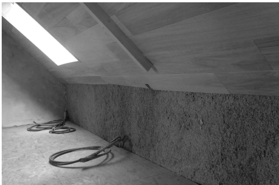
Posizionamento dei cavi elettrici prima dell'intonaco di finitura
