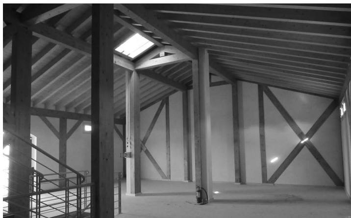
L'Acetaia: struttura in legno, pareti in Canapa e intonaci in Canapa e calce
