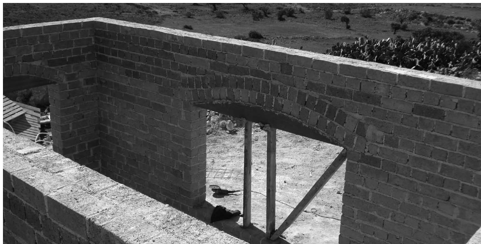
Murature portanti in blocchi di Canapa-terra-calce
