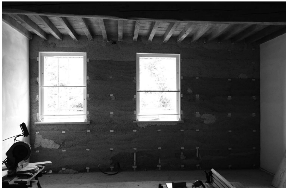
Cappotto interno in Canapa e calce completato
