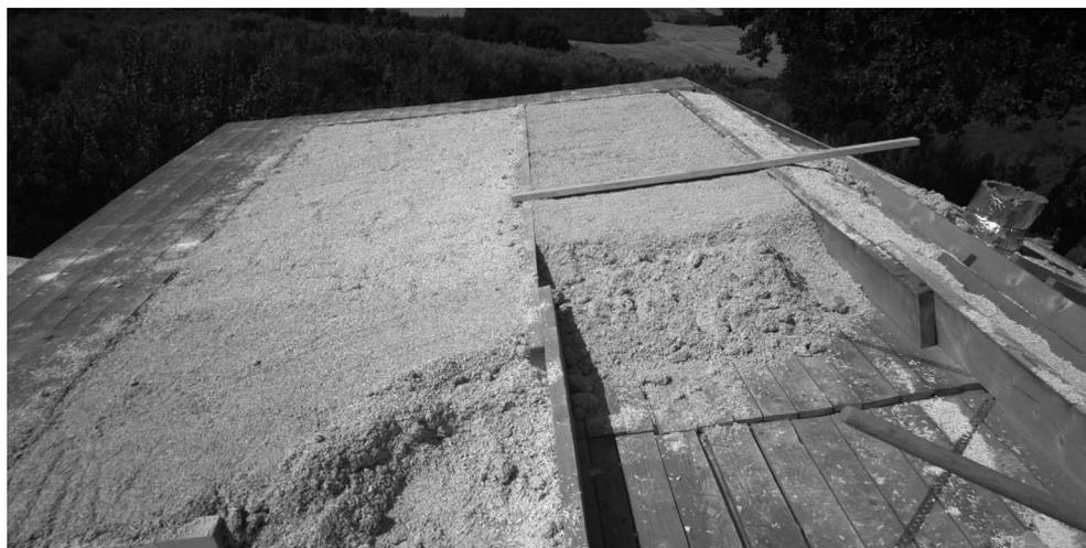
Isolamento del tetto con canapulo mineralizzato
