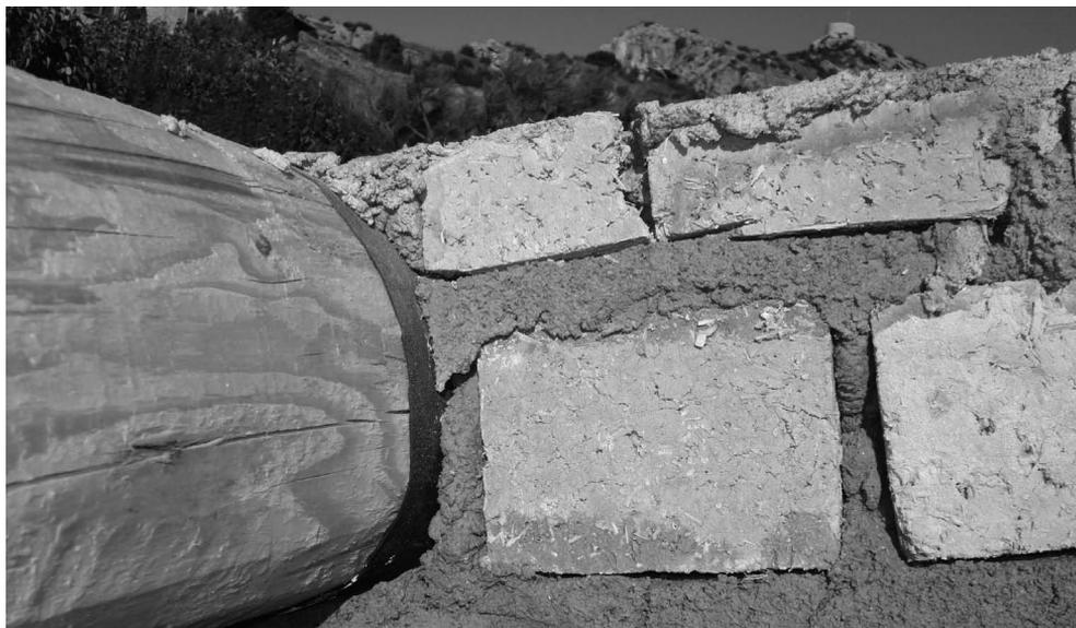
Travi di legno inserite nel muro in blocchi di Canapa
