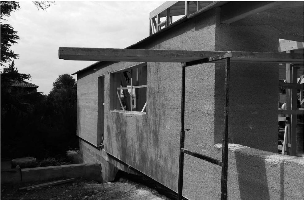
Muro di tamponamento in Canapa-calce
