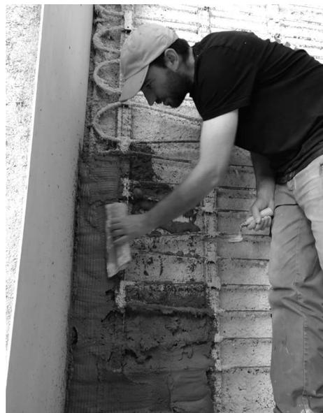
Posa di un intonaco di terra cruda sull'impianto di riscaldamento
